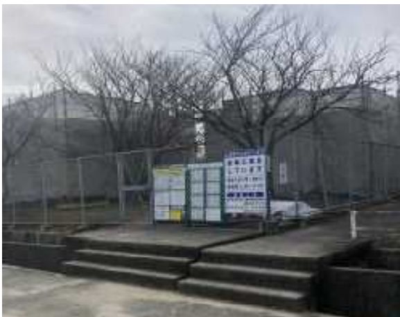
【足場が組まれたプール施設】
