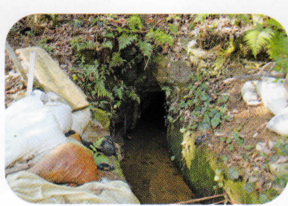
②③手掘りトンネル
