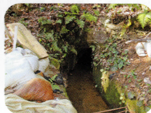
②③手掘りトンネル
