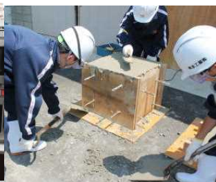
ヘルメットを着けて作業
