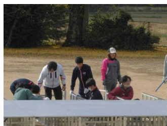
屋外ステージの設置
